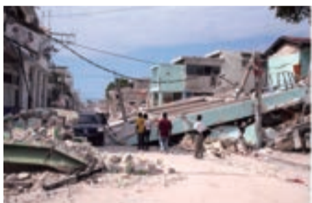
1月14日、ポルトープランスで倒壊した建物。がれきの下には遺体が残されたままだった。毎日新聞社提供
